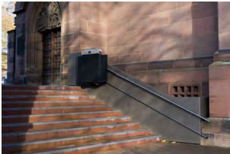
Barrierefreier Zugang vom Domplatz zum Kreuzgang
