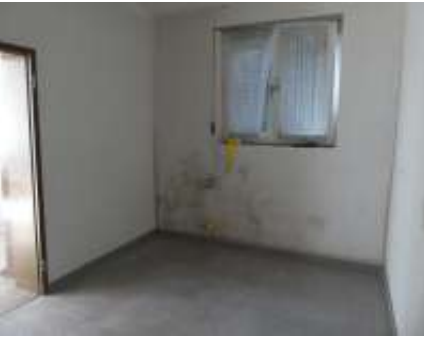
Die Baustelle im Martinushaus. Foto: Martina Bauer
